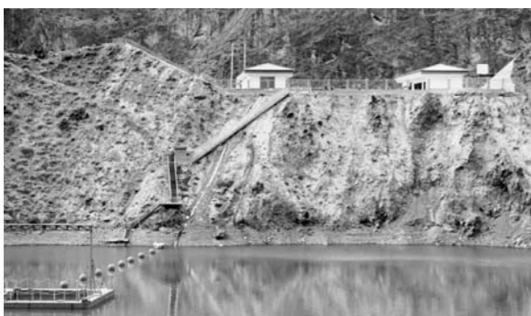
主动源重复探测项目建设现场
