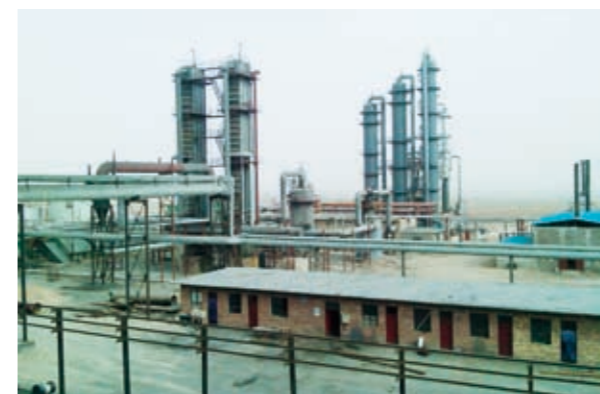
晋昌源公司化工产区
