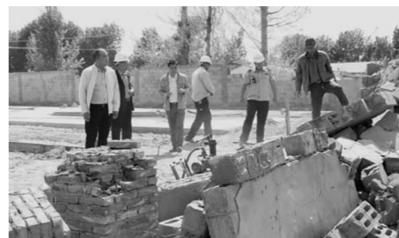
拆除违章建筑
