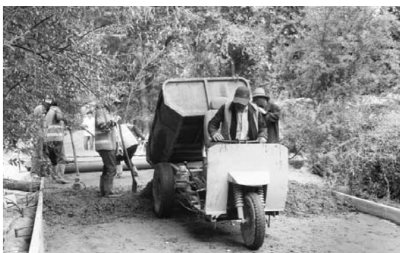
通村道路建设
